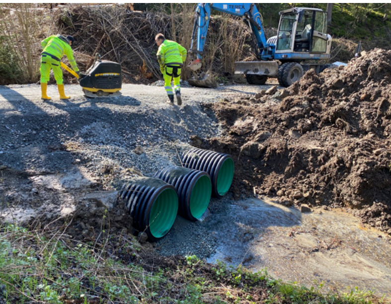
Abb.: Neubau Durchlass im Leugnitztal
