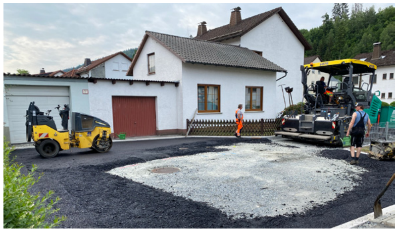
Abb.: Straßenerneuerungsarbeiten „Am Fallenholz“
